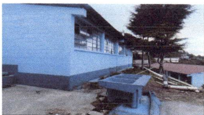
Foto 4: Pintura en muros exteriores e interiores
