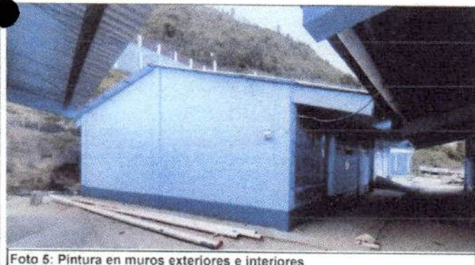
Foto 5: Pintura en muros exteriores e interiores
