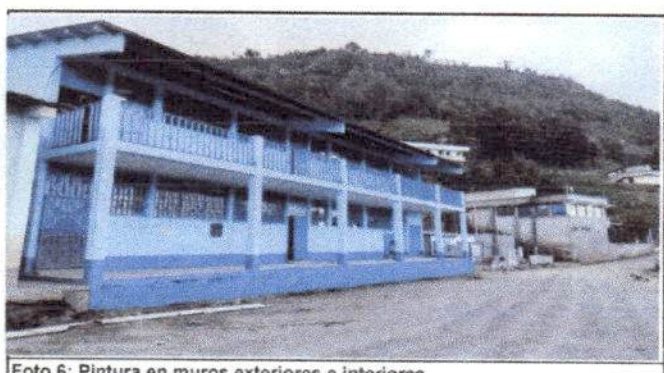
Foto 6: Pintura en muros exteriores e interiores
